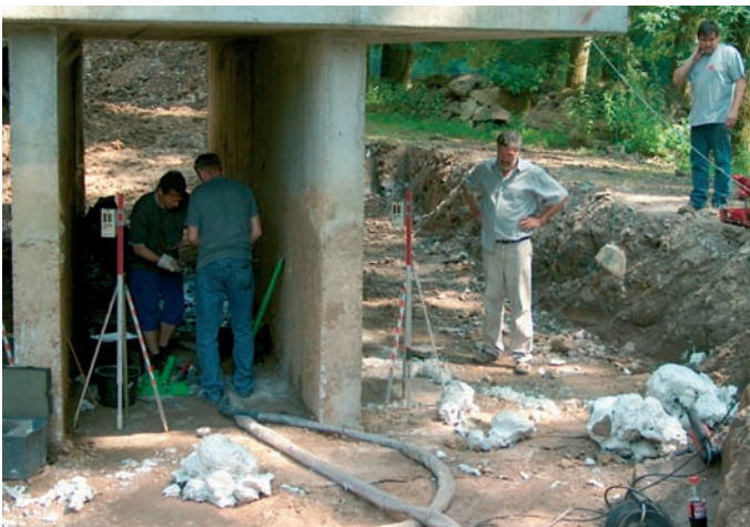
Hier deutlich zu erkennen: Die Betonplatte, auf der die Silokonstruktion steht. Das URETEK-Team injizierte unterhalb der Gründungsplatte das Spezial-Zweikomponentenharz. Auch zu erkennen: Geringfügiger Harzaustritt am Rand der Gründung.
