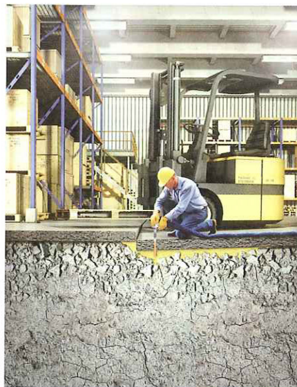
Bild 1. Anhebung eines Betonbodens
