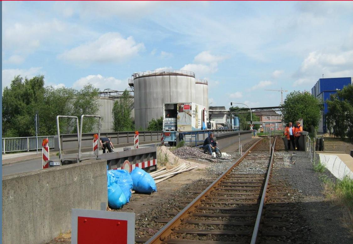
**An der Querkanalbrücke, die eine wichtige verkehrstechnische Überquerung innerhalb des Hamburger Hafens darstellt, sind am nördlichen und südlichen Brückenwiderlager Absenkungen im Fahrbahn- und Gleisbereich aufgetreten. Im Zuge von Reparaturarbeiten wurden beide Straßenrampen im Bereich des Brückenwiderlagers geöffnet, mit Sand wiederverfüllt und mit Asphalt überbaut. Zur Verdichtung der Sandverfüllung kamen URETEK-Injektionen zum Einsatz.**
