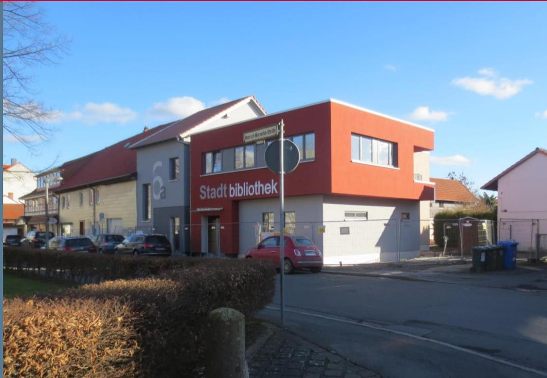
**Beim Bau der Stadtteilbibliothek Göttingen-Grone kam es zu Schwierigkeiten. Aufgrund einer falschen Einschätzung der Baugrundtragfähigkeit setzte sich das flachgegründete Gebäude bereits nach nur fünf Monaten Bauzeit um mehrere Zentimeter. Die Setzung des Gebäudes wurde von URETEK mittels Bodenverbesserungssäulen aus schnell aushärtender Expansionsharz gebremst.**
