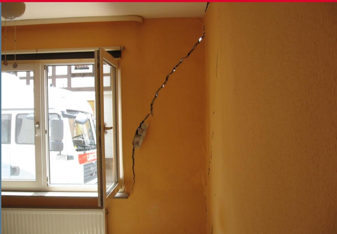
**An einem Wohnhaus in Elze sind infolge einer Kanalbaumaßnahme starke Risschäden aufgetreten. Eine Abhilfe verschaffte die URETEK-DeepInjection<sup>®</sup>-Methode. Mit Injektionen aus stark expandierenden Harzen wurden vorhandene Hohlräume aufgefüllt, der Baugrund verstärkt und dadurch eine Lagestabilisierung des Gebäudes erzielt.**
