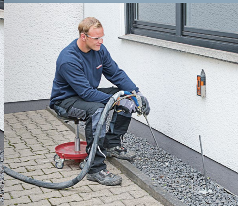
Die Injektion unserer Expansionsharze lässt sich durch den Einsatz von Laser- messtechnik millimetergenau steuern.
