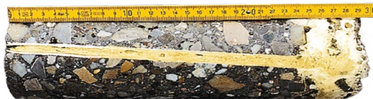
Der hier dargestellte Bohrkern zeigt links die Injektionslanze und rechts den mit dem URETEK Expansionsharz aufgefüllten Hohlraum.
