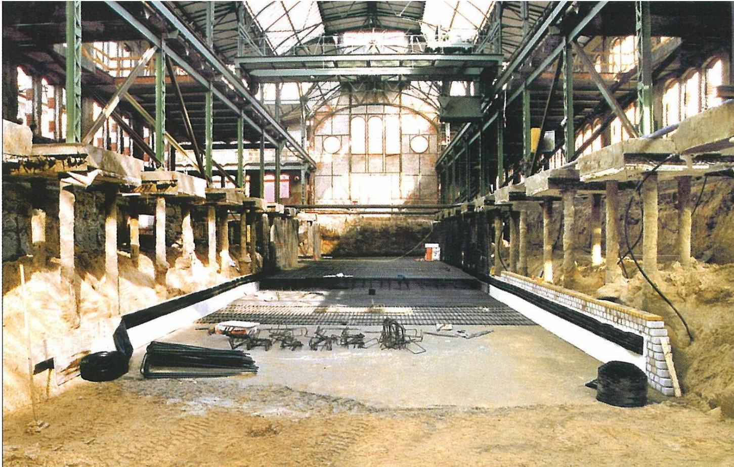
Unterfangung mit Mikropfählen, Berlin
