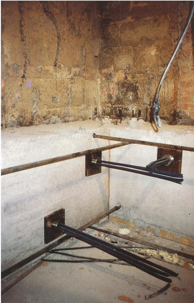
Streichbalken mit Ankerspannstählen
