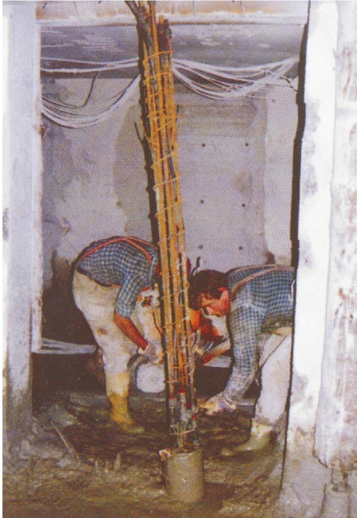
Einbau eines Kleinbohrverpresspfahles
