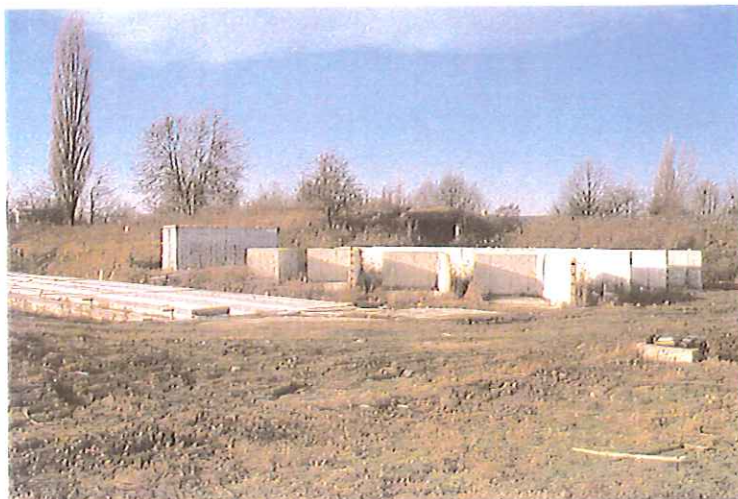
Bild 2: Versuchsfeld auf dem Freigelände des iBMB der TU Braunschweig
