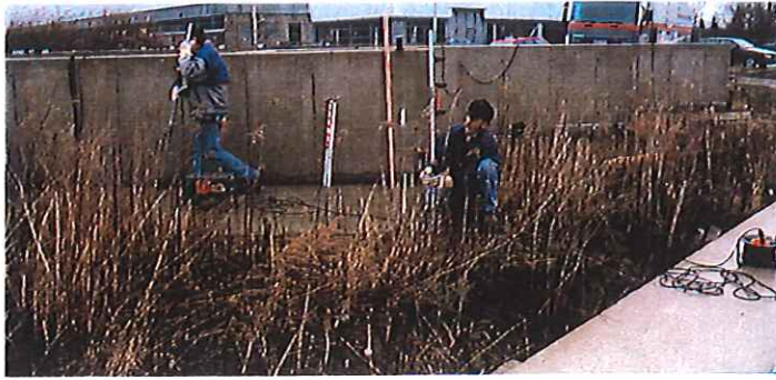
Bild 8: Einnivellieren des Versuchskörpers 1 vor Injektionsbeginn
