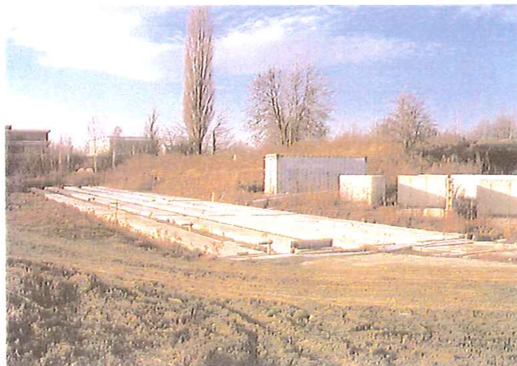
Bild 4: Versuchskörper 2 (Bodenplatten, im Vordergrund links)
