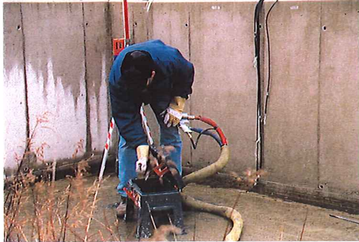
Bild 11: Injektionspistole mit Zuführungsschlauch
