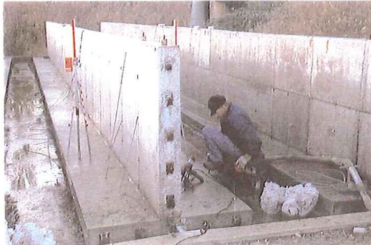
Bild 22: Injektion im Bereich des Meßpunktes 2 von Versuchskörper 3
